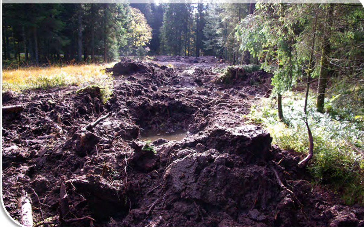
Travaux pour une piste de ski.
