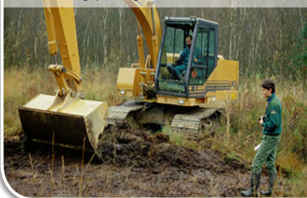
Opération d'étrépage en contexte tourbeux dans une Réserve biologique dirigée.
