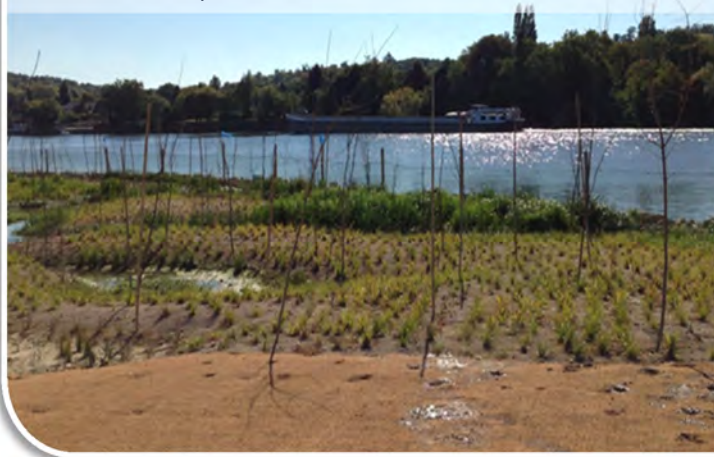
Plantation d'une grève alluviale en bordure de Seine après terrassement et pose d'un textile.
